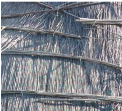
Le Barcarès, la baraque Canal, détail de la couverture.
